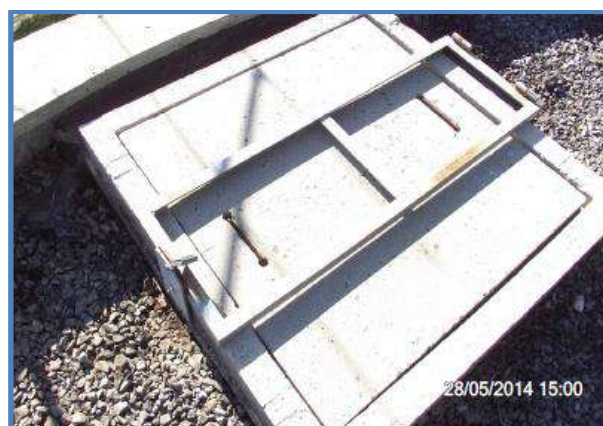
Imagem 21: Tampa da abertura de inspeção de um dos Reservatórios R 01.
