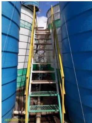
Foto 73 - Escada de acesso
