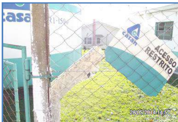
Imagem 18: Cerca instalada no entorno dos Reservatórios R 01.
