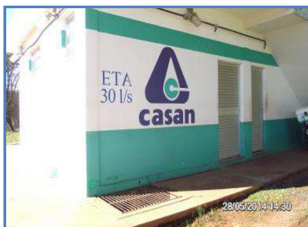
Imagem 3: Estação de Tratamento de Água.
