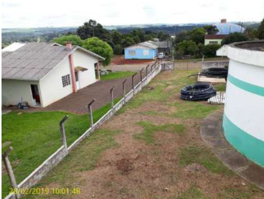
Foto 58 - Cerca em condições adequadas de conservação
