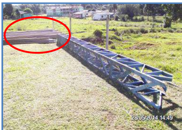
Imagem 8: Tubulações expostas às intempéries climáticas.
