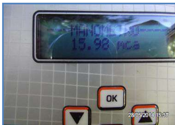
Imagem 37: Verificação da pressão.
