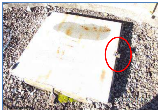
Imagem 31: Detalhe do dispositivo de travamento da tampa da abertura de inspeção do Reservatório R 02A.
