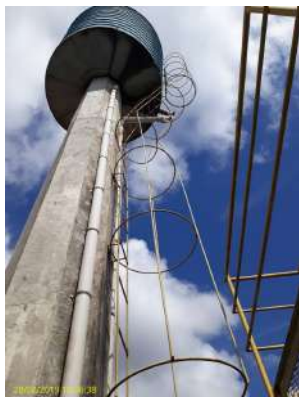
Foto 75 - Escada de acesso
