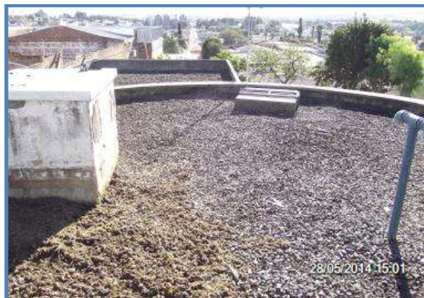
Imagem 25: Cobertura de um dos Reservatórios R 01.
