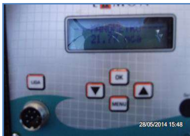
Imagem 40: Verificação da pressão.
