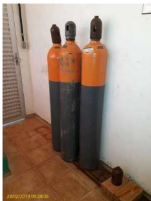
Foto 27 - Cilindros de cloro gás
