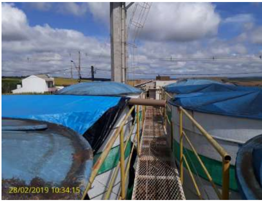
Foto 72 - Vista superior dos reservatórios
