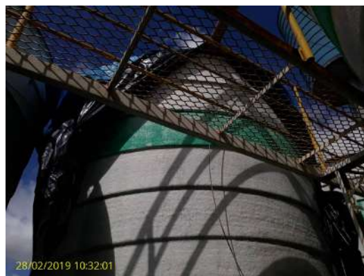
Foto 71 - Escada de acesso
