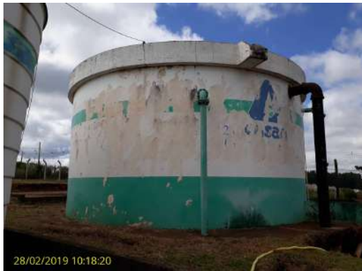
Foto 67 - Pintura inadequada
