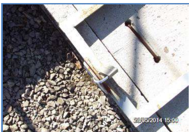
Imagem 20: Dispositivo de travamento da tampa da abertura de inspeção de um dos Reservatórios R 01.
