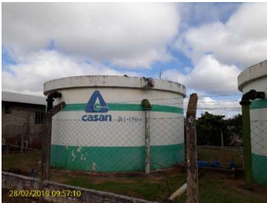
Foto 51 - Reservatório em concreto do tipo apoiado
