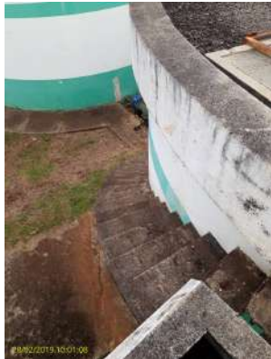
Foto 57 - Escada de acesso
